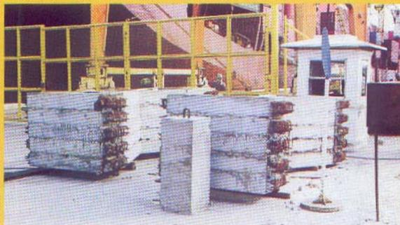
A fabricação e a estocagem dos pré-moldados foram feitas no próprio canteiro. A armadura (à direita) foi posicionada na fôrma da primeira peça da camada para a execução da concretagem. Em seguida, eram produzidas as outras peças, uma em cima da outra, separadas por uma camada de tinta betuminosa (à esquerda)
