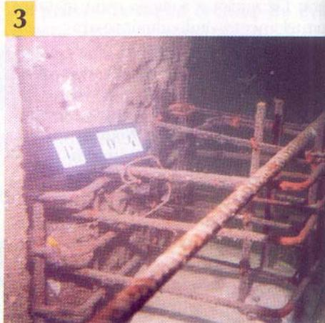
Para solidarizar o pré-moldado à estrutura existente foram feitas armaduras de aço que enlaçavam os arranques deixados nas peças
