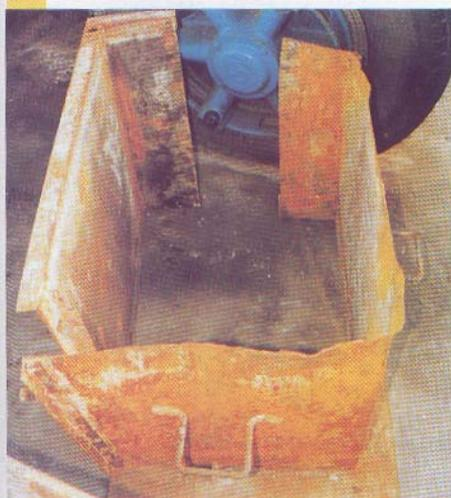
A etapa de confecção das fôrmas foi uma das mais trabalhosas da obra. Formadas por duas partes, os moldes quase não foram reaproveitados devido à diferença dimensional entre as partes da estrutura existente
