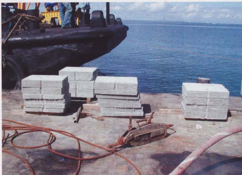
Apesar da retirada completa do material assoreado, alguns pontos permaneceram irregulares. Para que a cortina se mantivesse nivelada, a solução foi usar gabaritos e alguns calços de concreto pré-moldado
