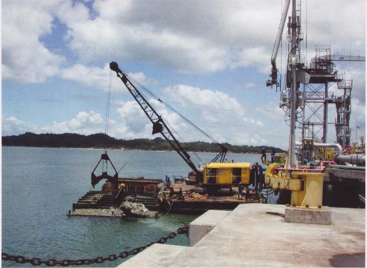
O material dragado do fundo do cais foi transportado em balsas e descartado em bota-fora adequado
